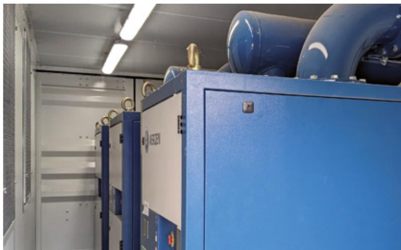
*Las turbosoplantes de la solución móvil de alquiler son de última generación. En caso necesario, se pueden adquirir e instalar de forma permanente en la nueva ubicación de la futura depuradora.*
