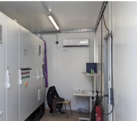
*El sistema de control de las turbosoplantes se aloja en un contenedor aparte. Como la tecnología de la depuradora quedó destruida por la inundación, el control de la solución móvil de alquiler funciona por separado.*
