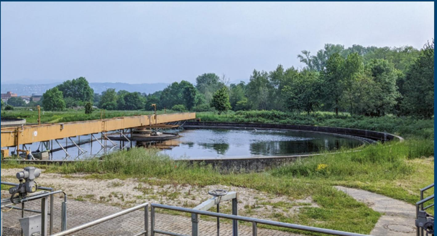
*La fase de aireación va seguida de un tratamiento secundario en la depuradora de Sinzig en dos tanques circulares.*
