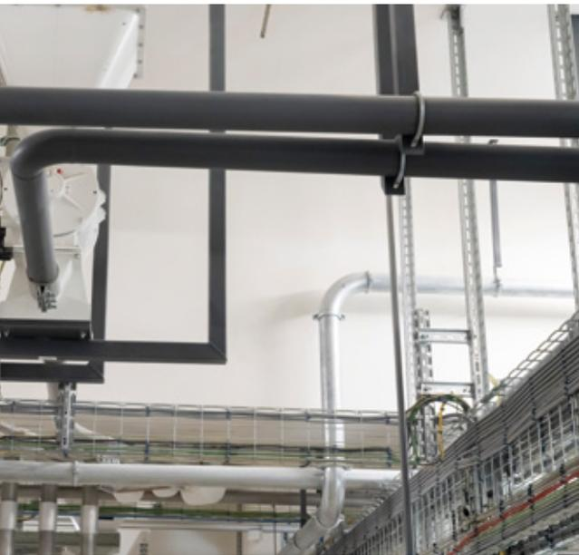
En la parte baja de cada tubería hay una soplante, y algunas conducen desde la planta baja hasta el octavo piso. Los tubos grises suministran el gas bruto. Cuando hay alimentos de por medio, se emplean tubos de acero inoxidable (plata).
