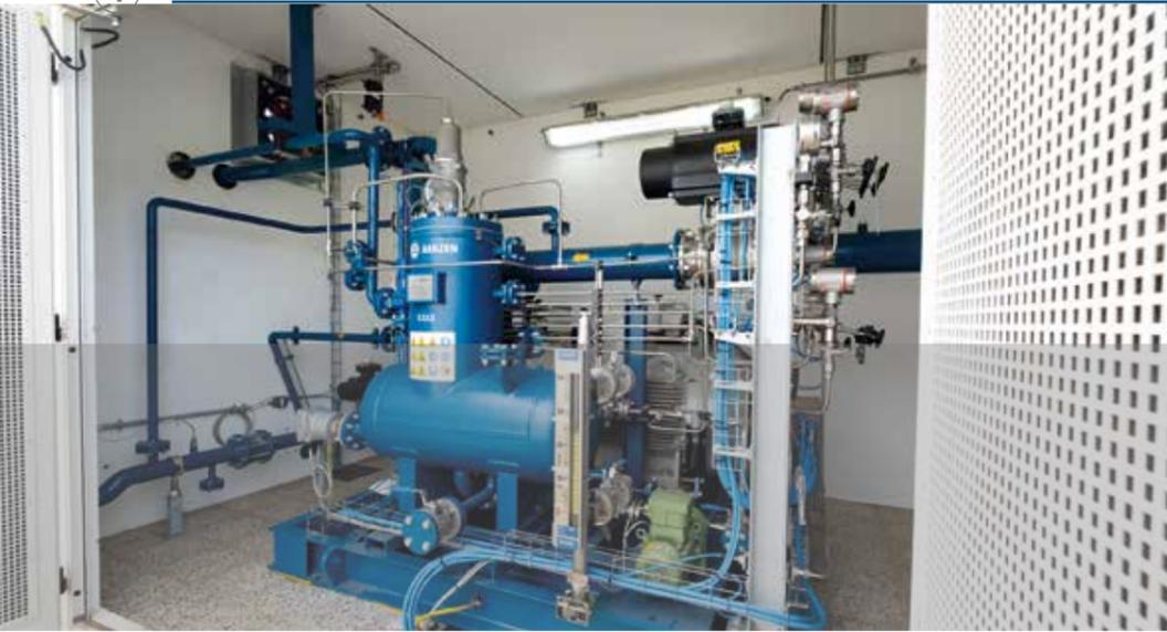
Los compresores de tornillo de AERZEN comprimen el biometano para abastecer la red local de gas.
