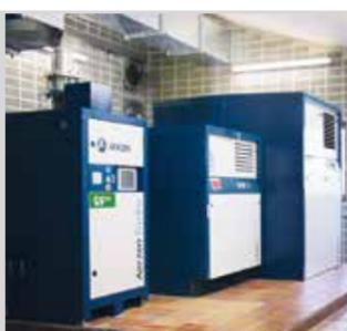
En la planta de tratamiento de aguas residuales de Oberschleißheim (Alemania), la combinación de tecnologías AERZEN Performance<sup>3</sup> – compuesta por una turbo, una soplante Delta y una máquina híbrida– garantiza un suministro eficiente de aire comprimido en los tanques de aireación.
