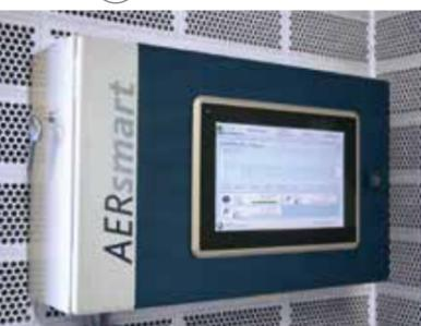
AERsmart, el sistema de control integrado de AERZEN, distribuye los caudales volumétricos necesarios a la maquinaria de tal modo que las cargas bajas, medias y altas se procesan con la máxima eficiencia posible.
