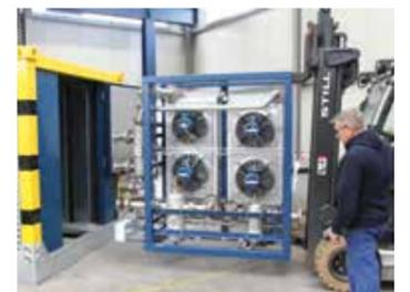
Una unidad de refrigeración posterior construida como un cajón: la instalación se realiza mediante carretilla elevadora y solamente en unos pocos pasos allá donde se necesite.
