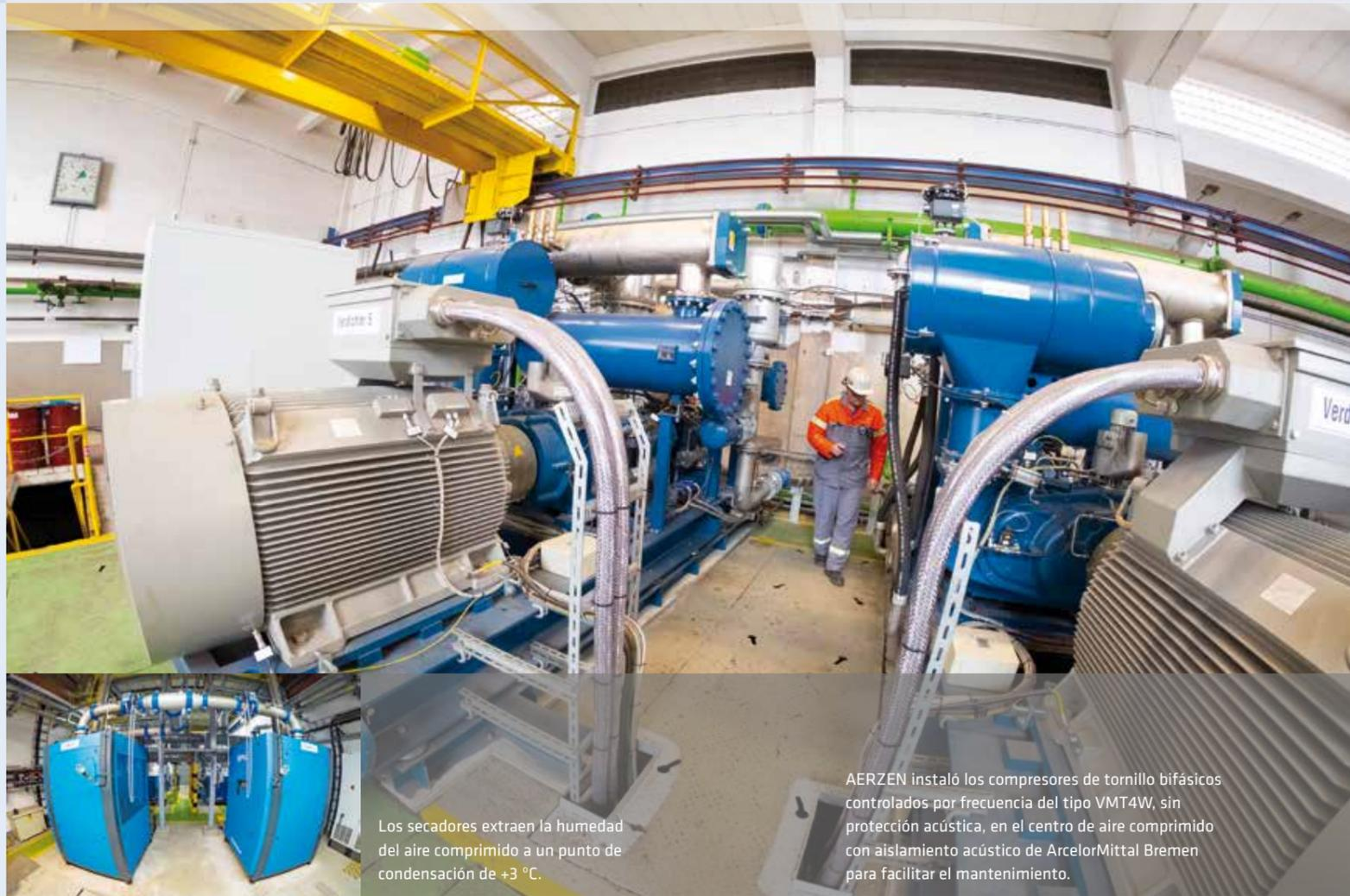
Los secadores extraen la humedad del aire comprimido a un punto de condensación de +3 °C.
