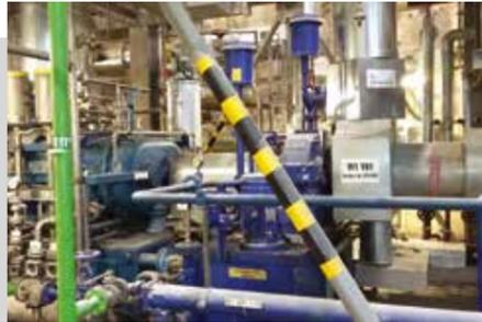
VKO 725S para comprimir gases de hornos de cal con propulsión de turbina construido en 1976.
