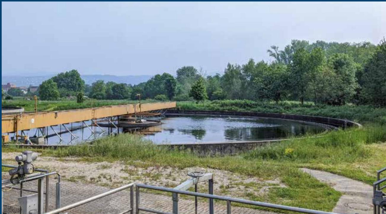
Auf die Belüftungsphase folgt die Nachklärung in der Kläranlage Sinzig in zwei Rundbecken.
