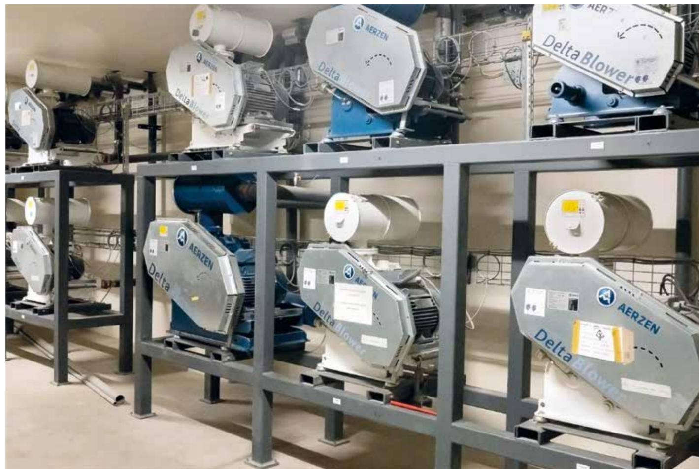
Insgesamt 21 AERZEN Drehkolbengebläse vom Typ Delta Blower halten die Flockenproduktion am Laufen.
