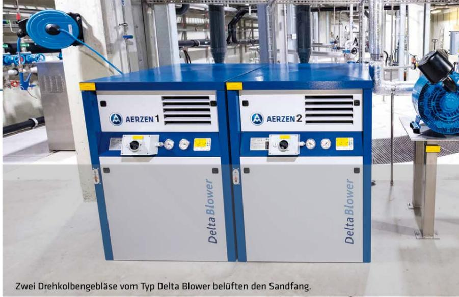
Zwei Drehkolbengebläse vom Typ Delta Blower belüften den Sandfang.
