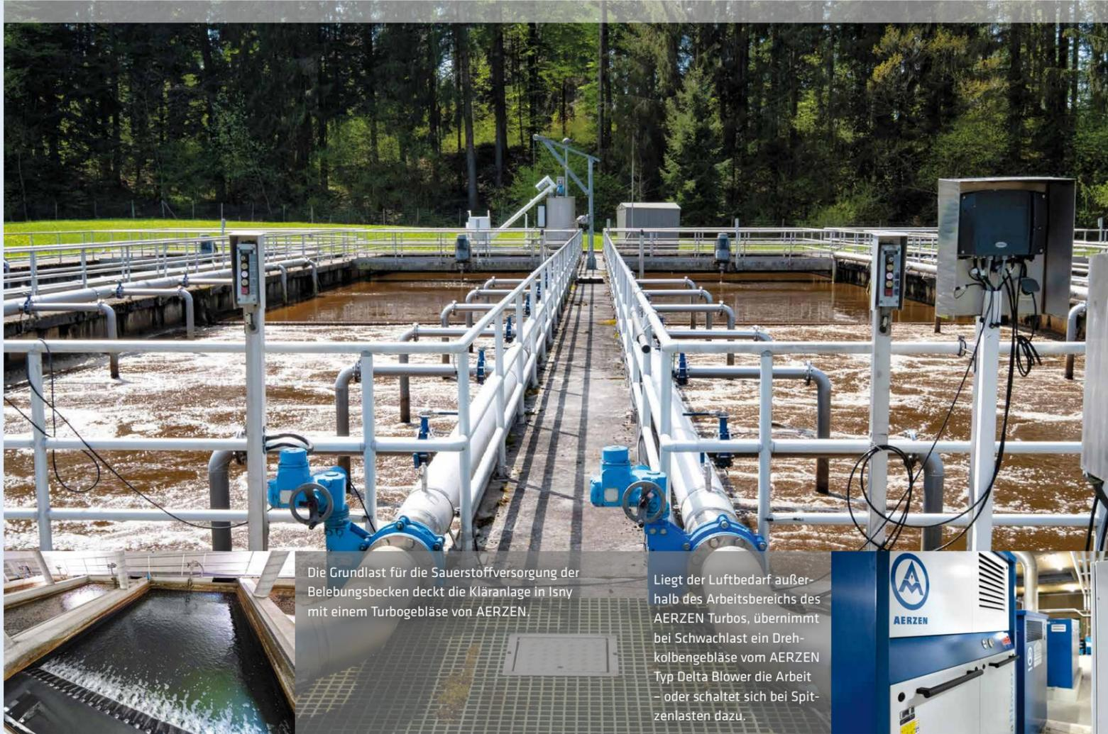
Die Grundlast für die Sauerstoffversorgung der Belebungsbecken deckt die Kläranlage in Isny mit einem Turbogebläse von AERZEN.
