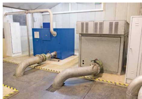
Neu trifft alt: Die in die Jahre gekommenen Bestandsgebläse dienen heute als Redundanz und Reserve für Lastspitzen.
