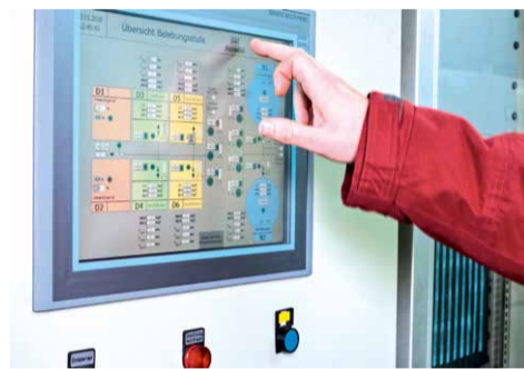
Per Touch Panel lässt sich die Gebläsetechnik vor Ort bedienen.
