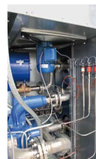
Der Luft-Luft-Nachkühler ist in das Aggregatgehäuse integriert.
