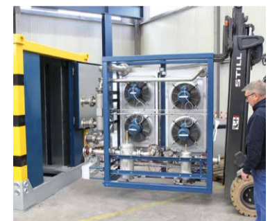
Eine Nachkühleinheit aufgebaut wie eine Schublade: Der bedarfsgerechte Einbau ist per Gabelstapler und mit wenigen Handgriffen erledigt.
