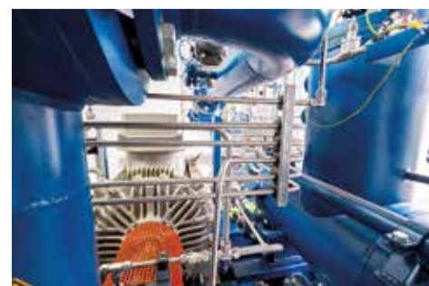
Jedes Aggregat liefert eine Fördermenge von 700 Normkubikmetern in der Stunde – und ist für diesen Einsatz nach ATEX zertifiziert.
