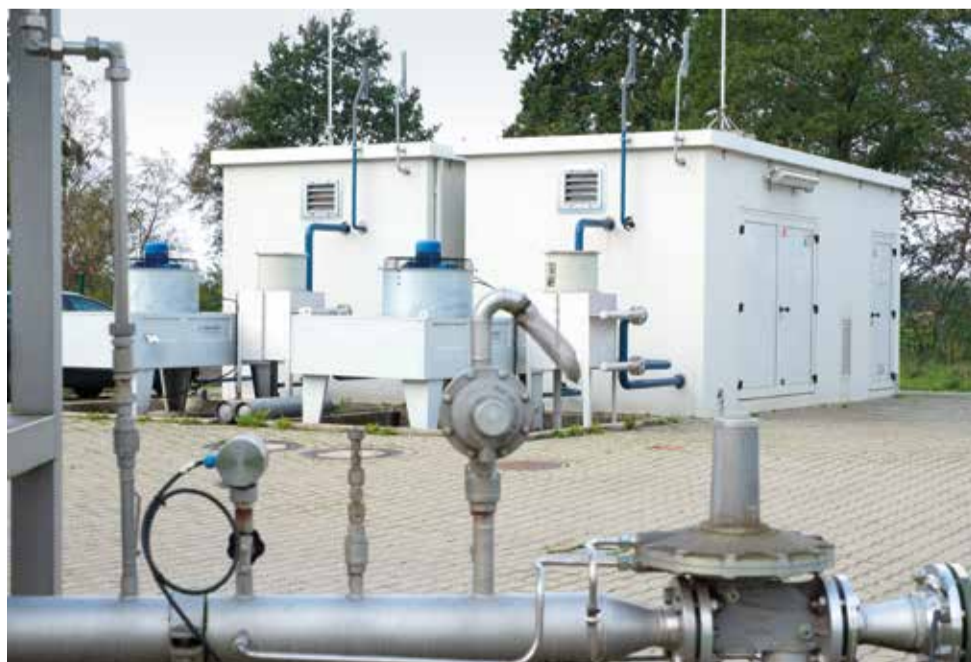
Jedes Aggregat liefert eine Fördermenge von 700 Normkubikmetern in der Stunde – und ist für diesen Einsatz nach ATEX zertifiziert.
