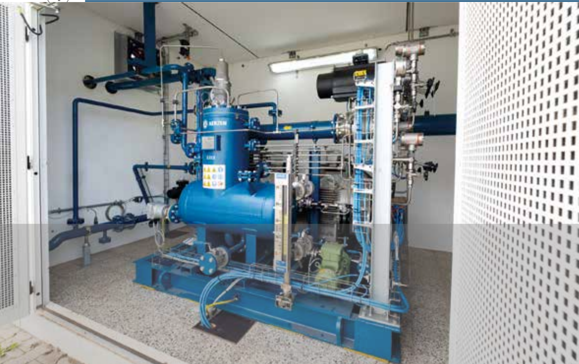
Schraubenkompressoren von AERZEN verdichten das Biomethan für die Einspeisung ins örtliche Gasnetz.
