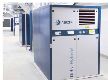
AERZEN Drehkolbenverdichter vom Typ Delta Hybrid D 52S sorgen für die optimale Sauerstoffversorgung der fünf SBR-Reaktoren.
