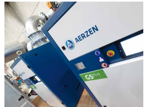
Zwei AERZEN Turbogebläse vom Typ AT100-0.6 S G5 plus liefern jeweils bis zu 70 Normkubikmeter pro Minute mit höchster Energieeffizienz.
